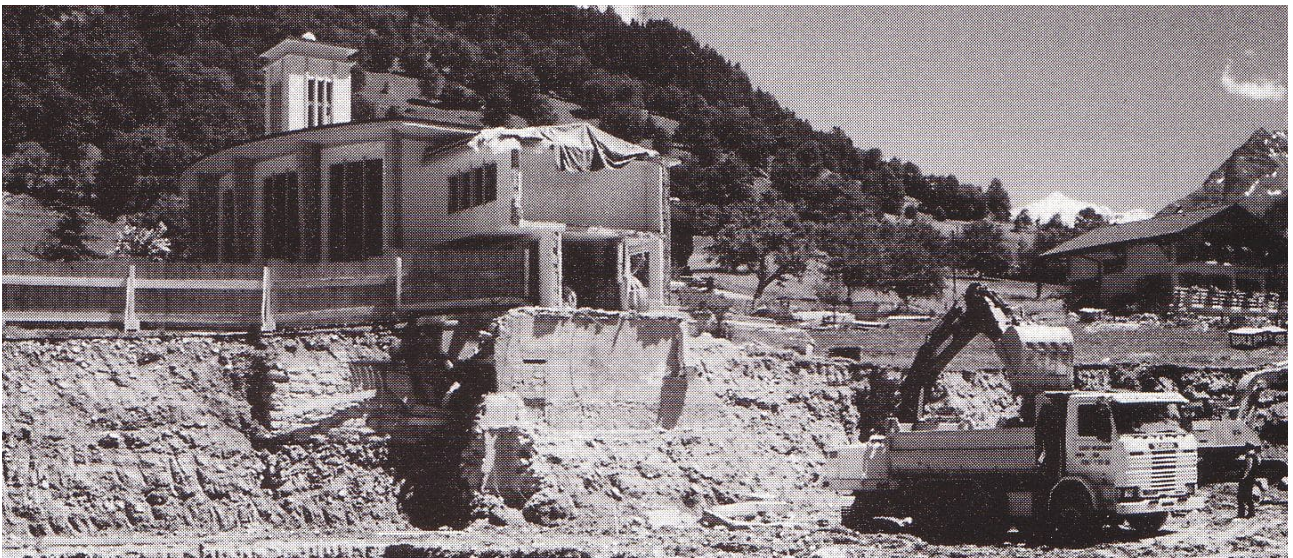
De 1987 à 1990, refonte complète du bâtiment. Seule la chapelle est conservée.
